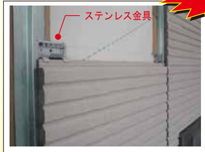
金具留め施工現場
